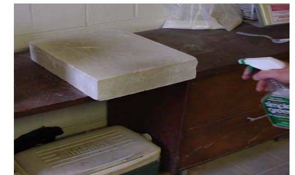
9. Humedezca el area reparada
