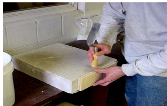
7. Compactar el area reparada
